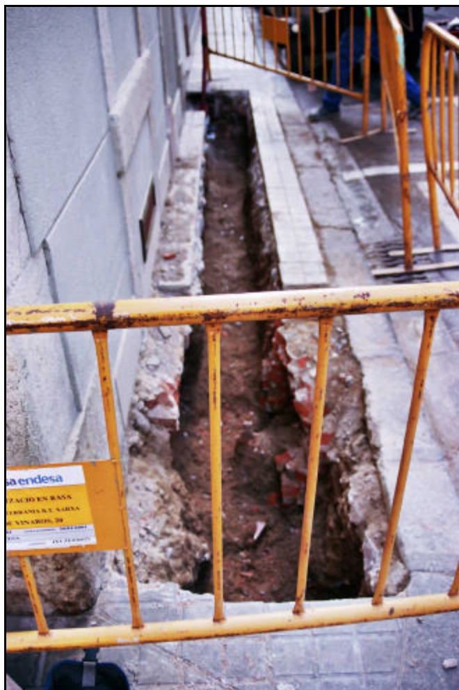
Fotografia 7. Detall rasa 1 realitzada al carrer Vinaròs.
