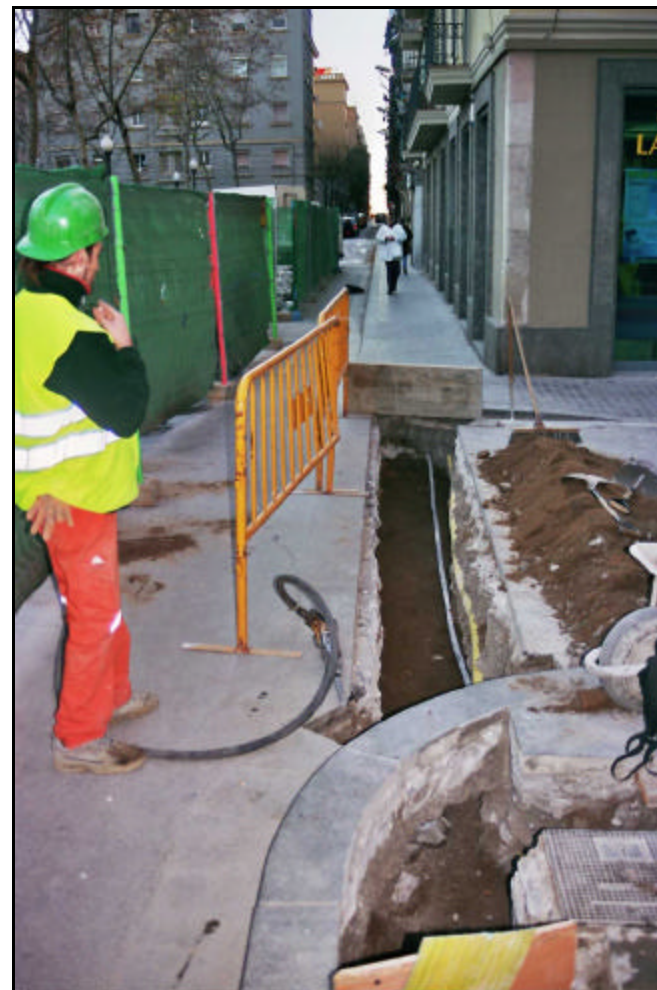
Fotografia 32. Detall nord- sud R/7-2, realitzada al carrer Baluard amb Escuders.
