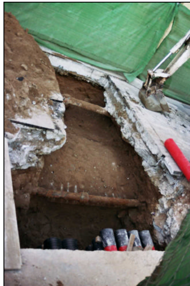
Fotografia 48. Detall oest- est de la rasa 13.
