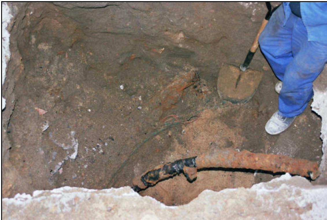
Fotografia 13. Servei de la llum fora de servei que va quedar al descobert un cop desmuntada l'arqueta contemporània localitzada al carrer Sant Carles, corresponent a la fotografia 12.
