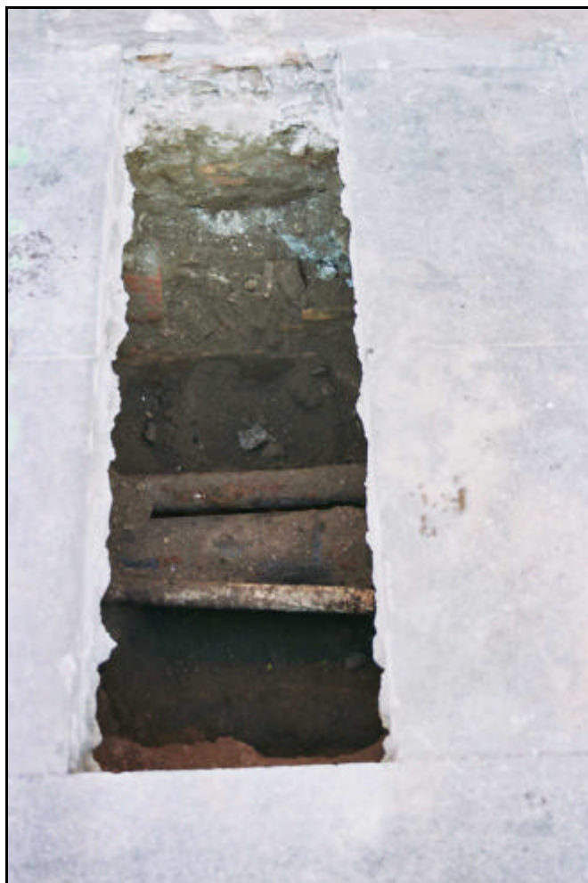
Fotografia 26. Detall oest- est de la cala 10, realitzada al carrer Atlàntida.
