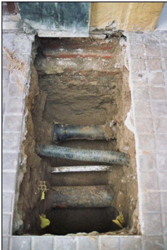
Fotografia 28. Detall oest- est de la cala 12, realitzada al carrer Atlàntida.
