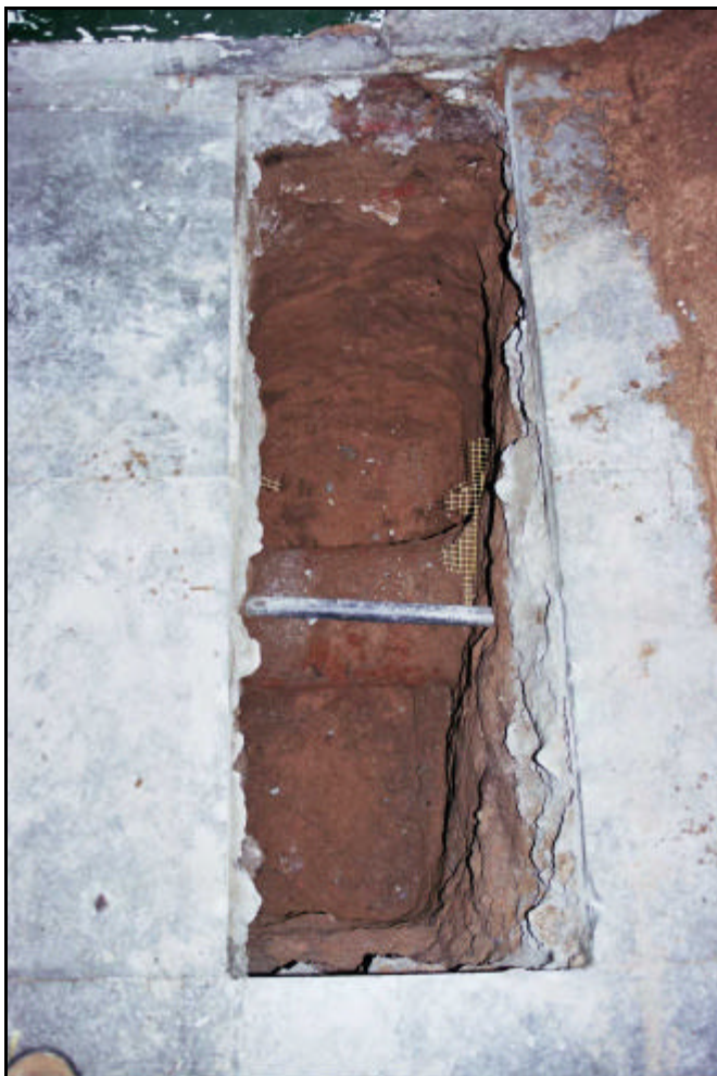
Fotografia 18. Detall est- oest cala número 4 realitzada al carrer Baluard.
