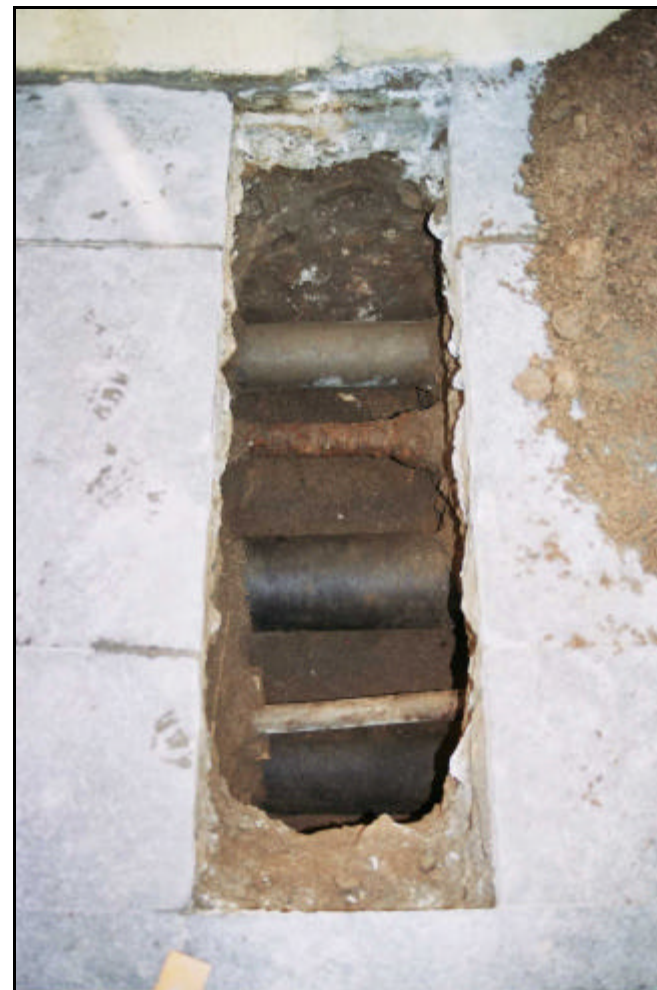
Fotografia 25. Detall oest- est de la cala 9, realitzada al carrer Atlàntida.
