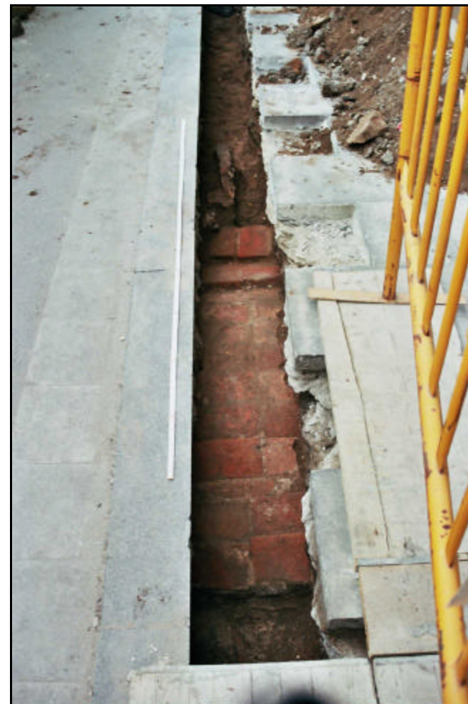
Fotografia 34. Detall nord- sud de la clavaguera contemporània localitzada a R/7-3.
