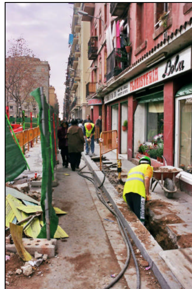
Fotografia 4. Detall treballs obertura R/7 al carrer Baluard.
