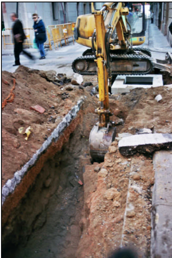
Fotografia 5. Detall treballs màquina retroexcavadora al carrer Sant Carles.
