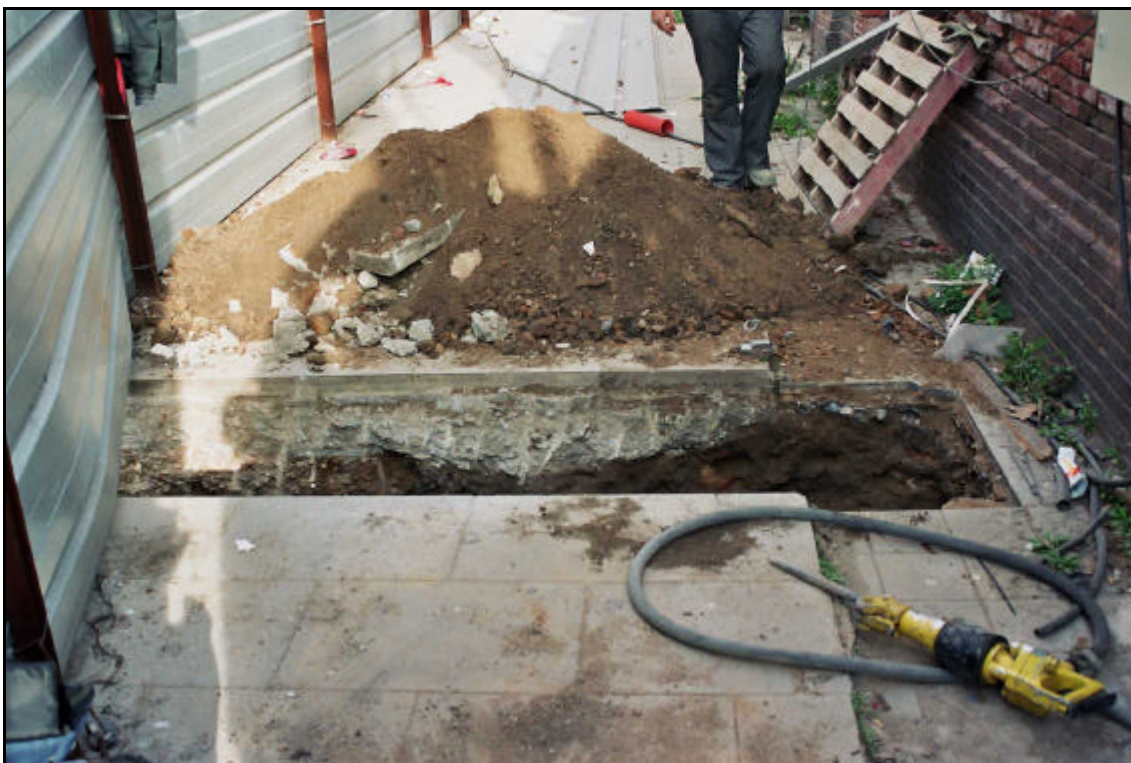
Fotografia 37. Detall oest- est de la rasa 8.
